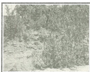
ภาพที่ 4 ถนนพริ้งดงาม เป็นกำแพงก่ออิฐกรอบถนนดิน
