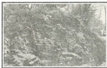
ภาพที่ 1-2 กำแพงเมืองเชียงแสน ลักษณะเป็นกำแพงก่ออิฐกรอบแกนดิน
