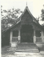
ภาพอุโบสถหลังเดิมก่อนการรื้อถอนสร้างหลังใหม่ทดแทน
