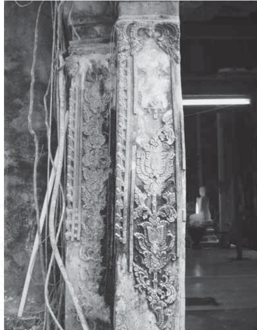
ลวดลายปูนปั้นประดับเสากรอบประตูทางเข้าด้านหน้า
