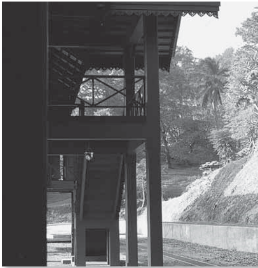
บันไดทางลงจากทางเดินเชื่อมชั้น ๒
