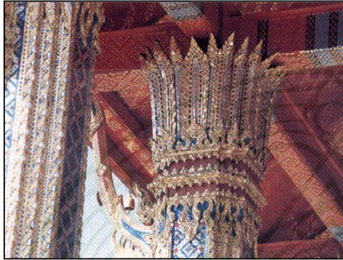
เสาพระอุโบสถวัดพระศรีรัตนมหาธาตุ เป็น เสาเครื่องก่อ ย่อมุมไม้สิบสอง บัวหัวเสา แบบบัวจกล
