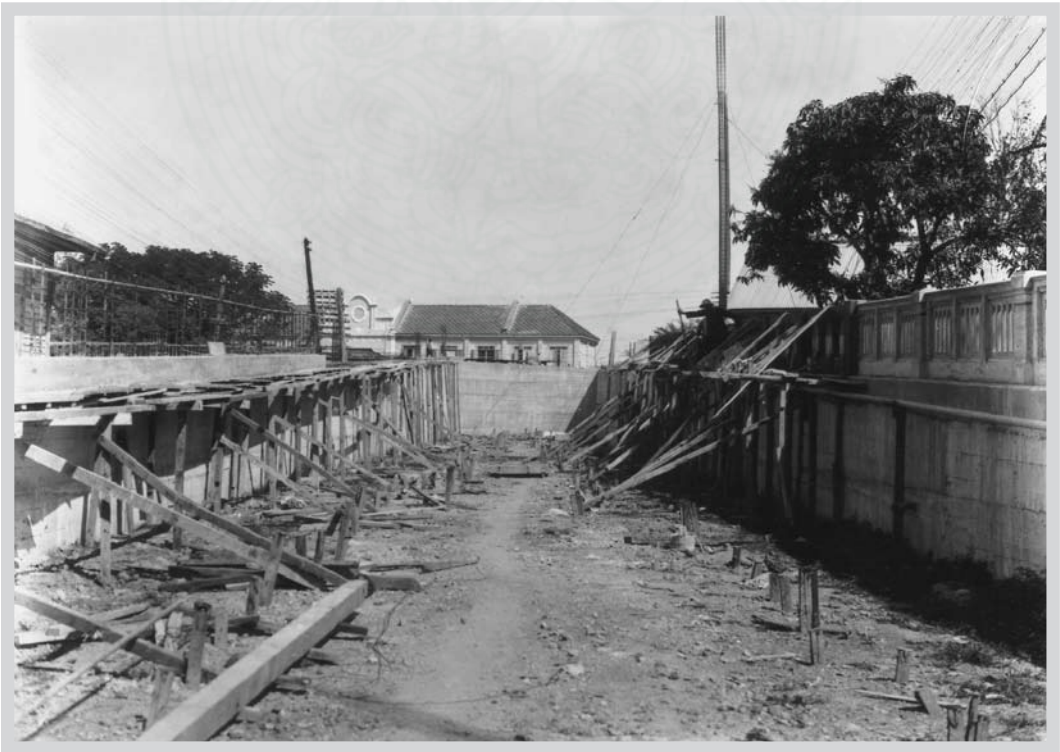
การก่อสร้างสะพานกษัตริย์ศึก โดยบริษัทบางกอกต็อก จำกัด เป็นผู้รับเหมาก่อสร้าง
