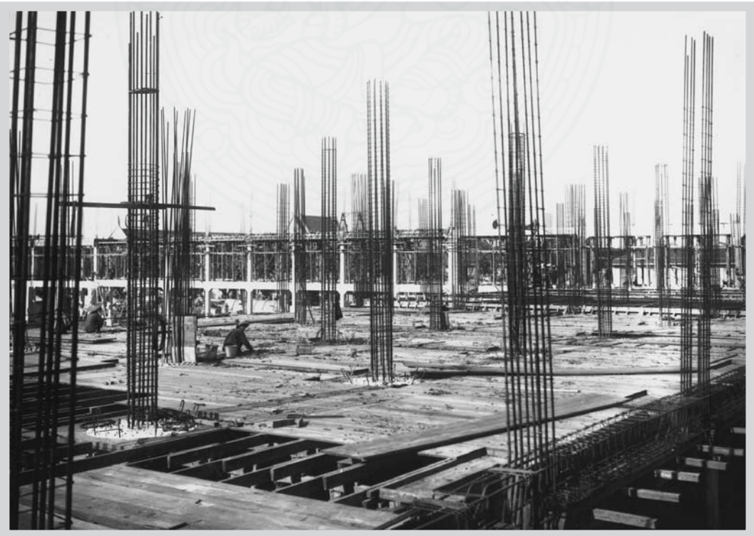
พนักงานบริษัทบางกอกดีค จำกัด ขณะเทปูนโครงสร้างเหล็กระหว่างก่อสร้างสะพานกษัตริย์ศึก
