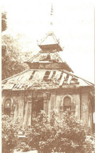
หอไตรวัดดวงดี ถ่ายก่อนบูรณะ
