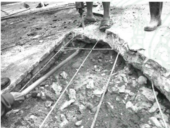
เมื่อเปิดพื้นปูหนาประมาณ ๒๐ เซนติเมตร ออก พบทรายสีน้ำตาลและเหล็กเส้น
