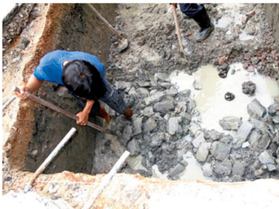
การทำงานที่ระดับ ๑๓๐ - ๑๕๐ cm.dt. น้ำใต้ดินไหลซึมเร็ว
