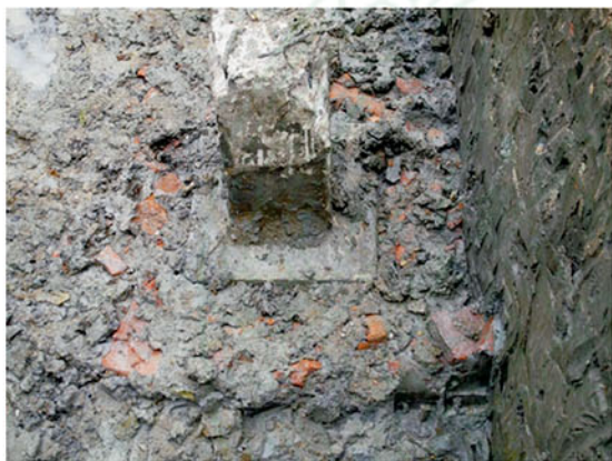
ได้เสาปูนพบเศษอิฐหักถมทำฐานราก
