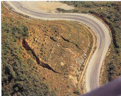
การก่อสร้างถนนคดเคี้ยว ก่อให้เกิดการเลื่อนไหลของดิน
