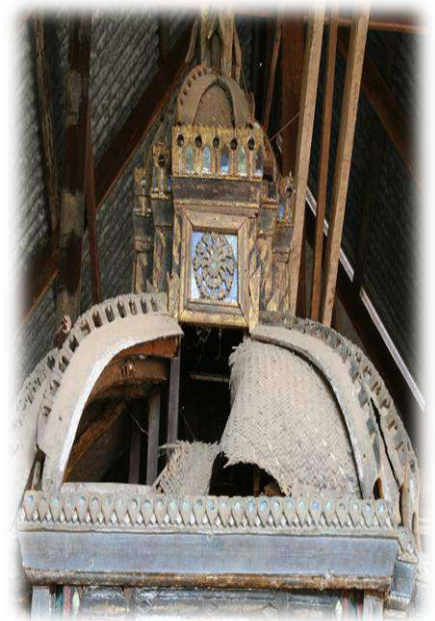
ชั้นหลังคามุงด้วยไม้ไผ่จักสานลายขัดแตะ วัดบ้านตลาด
