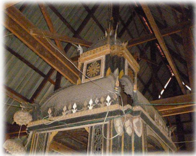
ชั้นหลังคามุงด้วยไม้ไผ่จักสาน สภาพก่อนข้างสมบูรณ วัดโพธิ์ชัย
