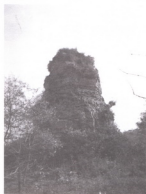
รูปที่ ๖ องค์พระธาตุหนองห้า ก่อนการบูรณะ สภาพชำรุดโทรม ส่วนบนคือมณฑปมีรูปที่ ๗ ขึ้น ไปพังทลาย และอิฐฟิซขึ้น ปกคลุมโดยทั่วไป ภายหลังด้าน ทิศเหนือ
