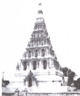
รูปที่ ๑ พระเจดีย์เหลี่ยม (รูปคำ) ตั้งอยู่ใน วัดเจดีย์เหลี่ยม ต.ท่าวังศาล อ.สารภี จ. เชียงใหม่ (สภาพก่อนการบูรณะ)
