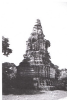
รูปที่ ๒ พระเจดีย์วัดศรีชุม ภาพถ่าย ก่อนบูรณะ ภายหลังเกิดเหตุการณ์ แผ่นดินไหว
