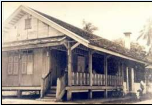
อาคารห้องผ้าตัด (ที่ทำการผ้าตัด)
