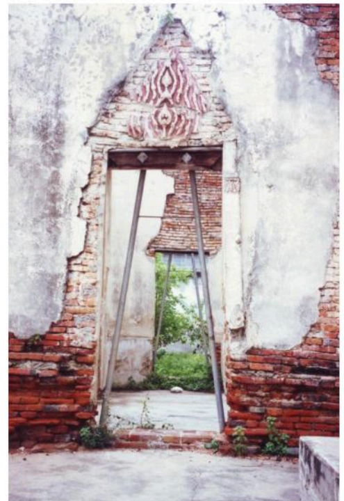
ประตูด้านข้างทางทิศใต้ของอาคารส่วนหลัง หน้าบ้านซุ้มประตูเป็นลายปูนล้อมรอบด้วยลาย กนกแปลง
