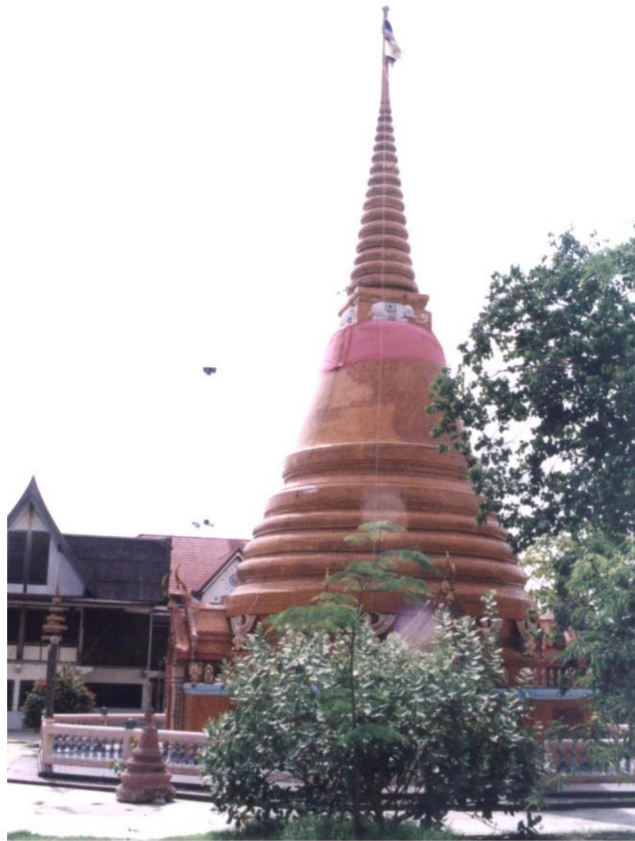
เจดีย์ก่ออิฐถือปูนประดับกระเบื้องเคลือบทรงระฆัง
