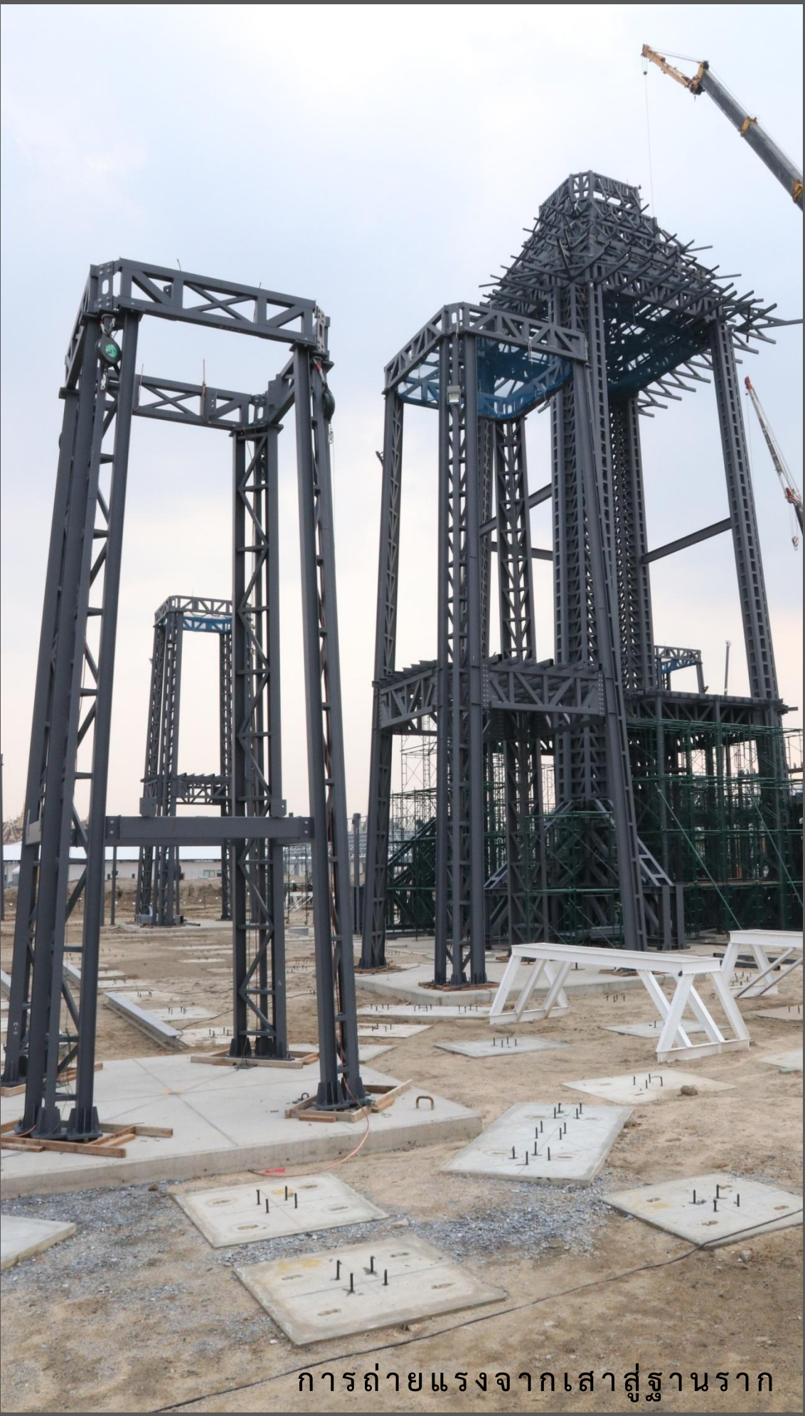
การถ่ายแรงจากเสาสู่ฐานราก
