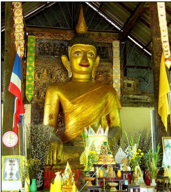
พระประธานในวิหาร ที่โครงสร้าง หลังคาและเสาส่วนใหญ่พังทลายลง โดยที่ผนังไม้ด้านหลังรวมถึงซุ้ม ยังคงมีร่องรอยการปิดทองล่องชาด เป็นรูปอดีตพุทธ และลายพรรณ พฤกษาในหลายรูปแบบ
