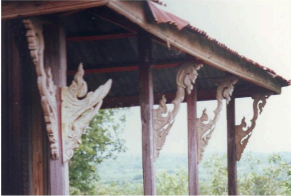
คันทวยรองรับชายคาปีกนก เป็นไม้จำหลักลวดลายงดงาม
