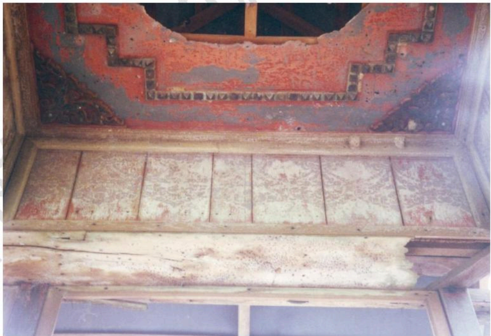
ภาพเขียนบนแผ่นไม้คอสอง มณฑปครอบรอยพระพุทธรบาท สภาพลบลือนมาก
