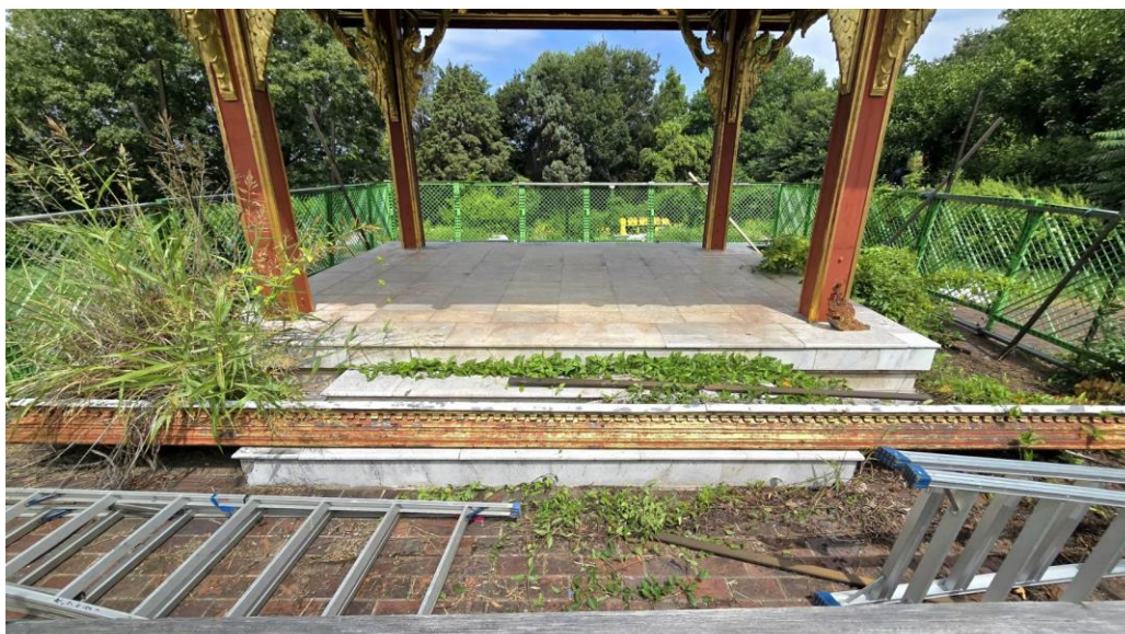
สภาพส่วนฐานอาคารทรวดโถม
