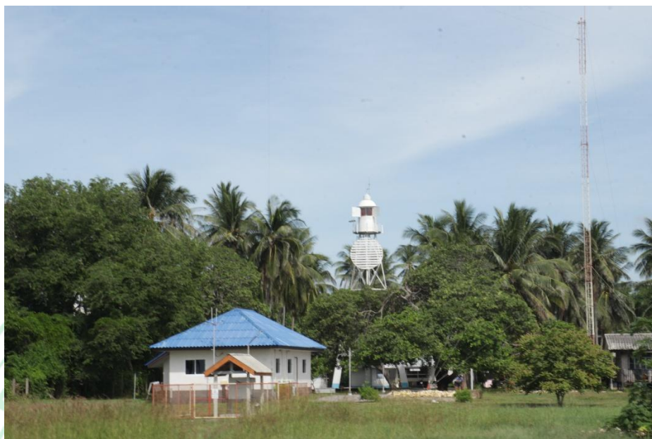
กระโจมไฟหลังสวน ตั้งอยู่บริเวณปากน้ำหลังสวน สร้างเมื่อ ๒๔๕๓ เป็นกระโจมคอนกรีตและเสริมเหล็กโปร่งทาสีขาว สูง ๑๗ เมตร
