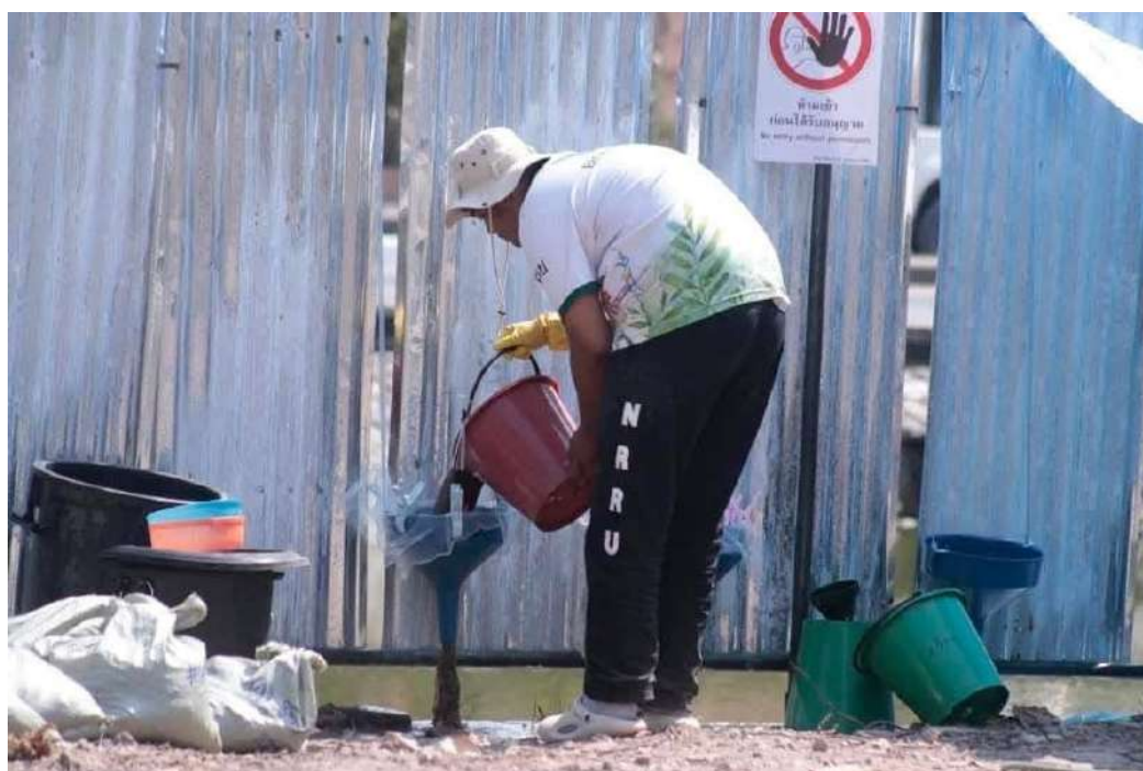
ภาพที่ 3.15 ดำเนินการกรองตะกอนดิน
