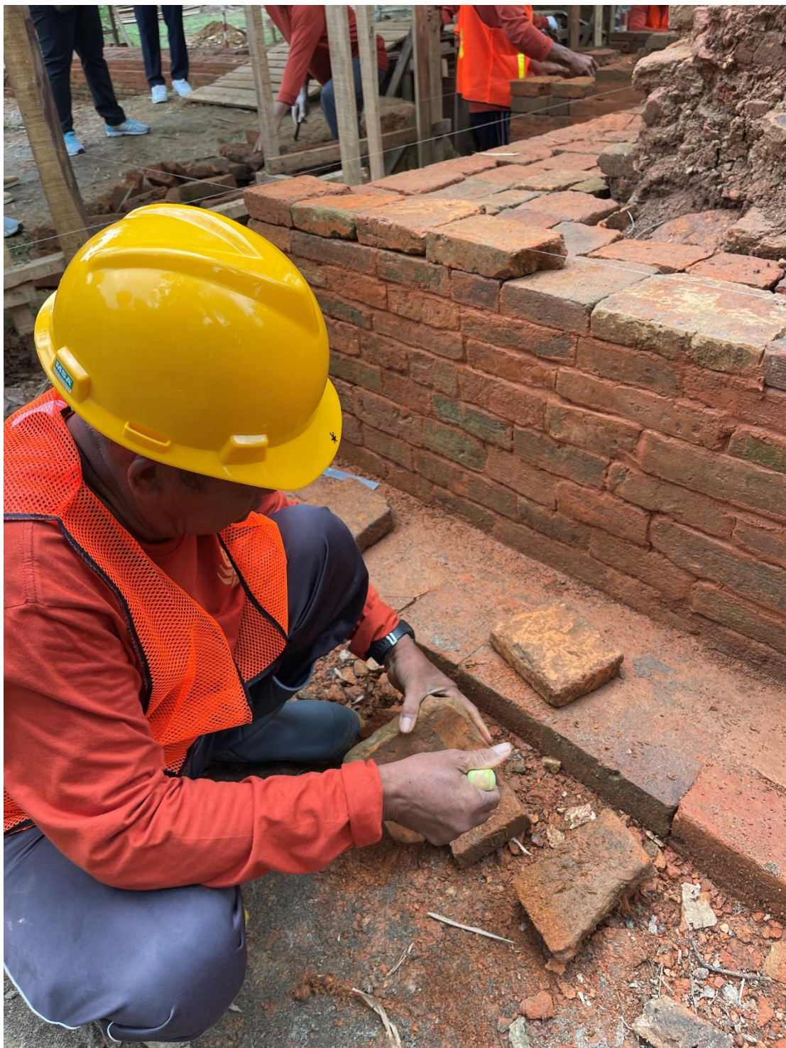
การปรับแต่งขนาดอิฐเดิม เพื่อนำกลับไปบูรณะโบราณสถานหลังการขุดแต่งเสร็จสมบูรณ์แล้ว
