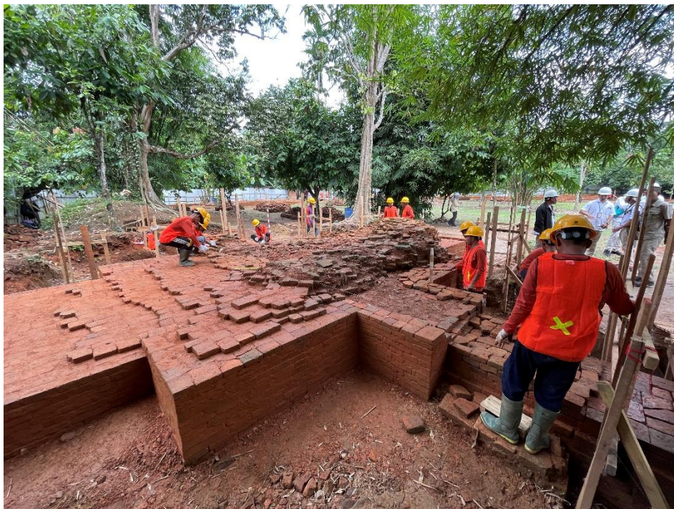
บรรยากาศขณะดำเนินการขุดแต่งและบูรณะโบราณสถานหนึ่งในเมืองมัวอาราจัมปี
