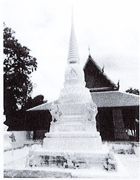
เจดีย์องค์กลางเมื่อบูรณปฏิสังขรณ์ งานศิลปกรรมแล้วเสร็จ
