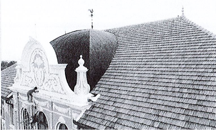
ส่วนหลังคาของอาคาร ประดับบราลิดินเผา บริเวณมุมหลังคาเสา บอกทิศทางรูปไก่ และเสาธงโลหะ
