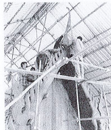
เครื่องสำยองที่รื้อฟื้นขึ้นมาตามรูปร่างดั้งเดิม ในขณะที่ดำเนินการติดตั้ง
