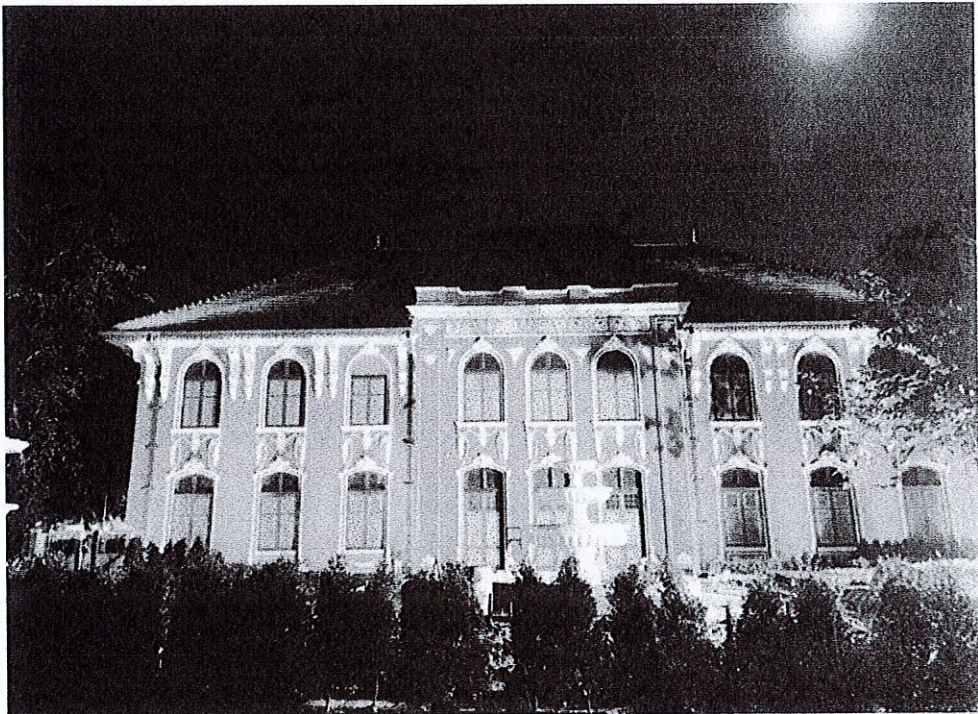
บรรยากาศด้านหลังอาคาร หลังการบูรณปฏิสังขรณ์
