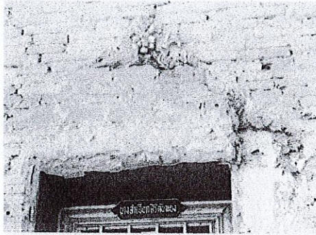
ลวดลายปูนปั้นซุ้มหน้าค้ำดั้งเดิมที่หลงเหลืออยู่ พบเมื่อสัปดาห์ก่อนหน้าค้ำที่ทางวัดก่อทับไว้ในยุคหลังออก
