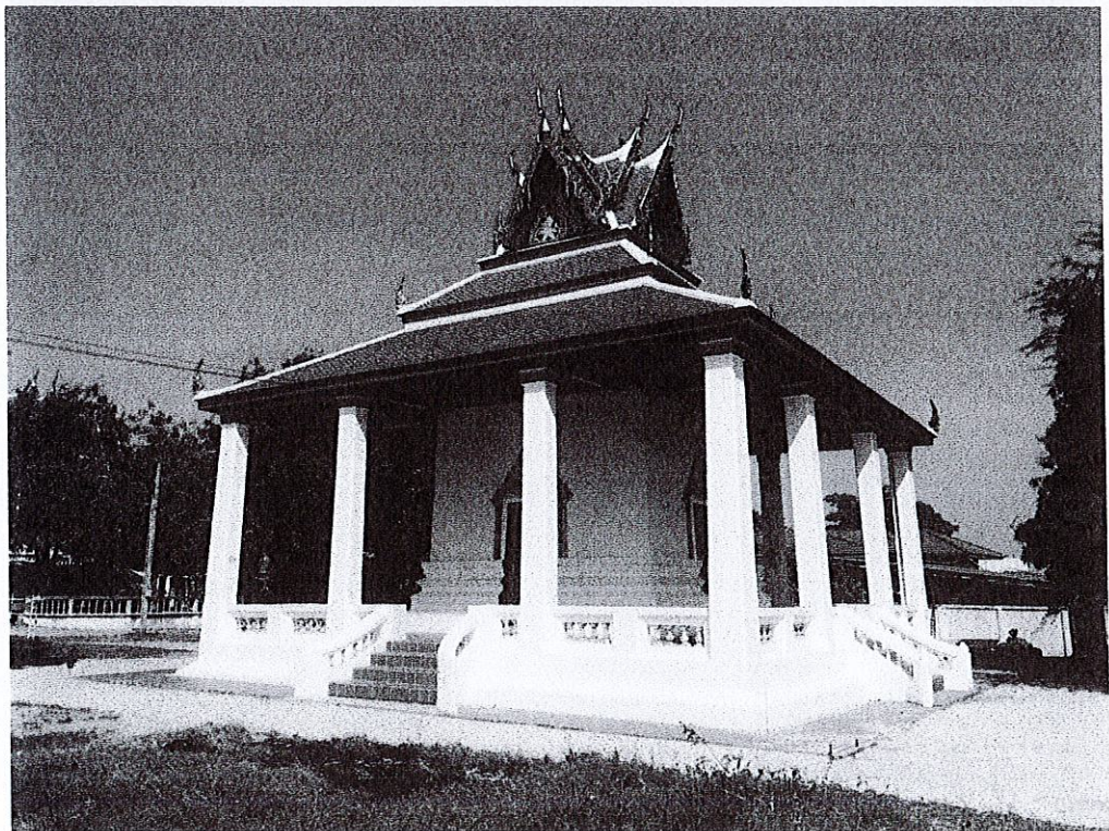
ภาพก่อนและหลังการบูรณปฏิสังขรณ์มณฑป วัดอ่างศิลา จ.ชลบุรี
