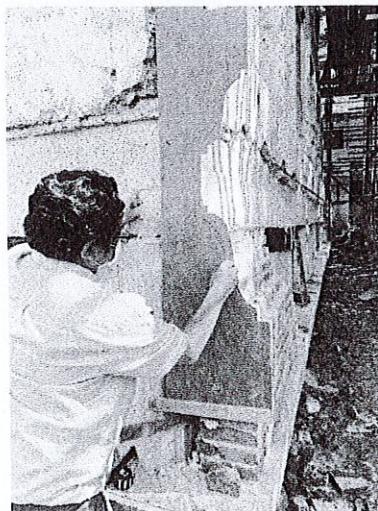
การปรับแก้ไขแบบขยายรายละเอียดและตัวอย่างขั้นฐานบัวก่อนดำเนินการก่ออิฐและถมพื้นปรับระดับ
