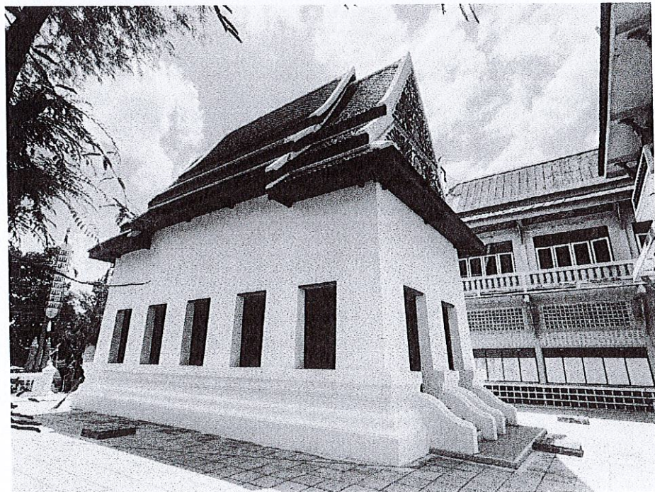
ภาพบรรยากาศเมื่อบูรณปฏิสังขรณ์และปรับปรุงทัศนแล้วเสร็จ
