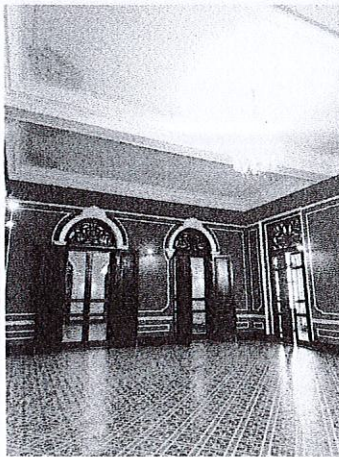
ไม้ฉลุลายเทือของประตู ช่วยให้ลมและแสงสว่างเข้ามาภายในอาคาร
