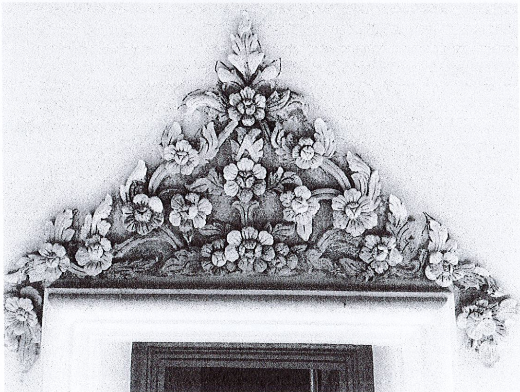
การตรวจพบหลักฐานและร่องรอยปูนปั้นประดับซุ้มหน้าต่างตามรูปแบบดั้งเดิม วิหาร (อุโบสถเก่า) วัดอ่างศิลา จ.ชลบุรี
