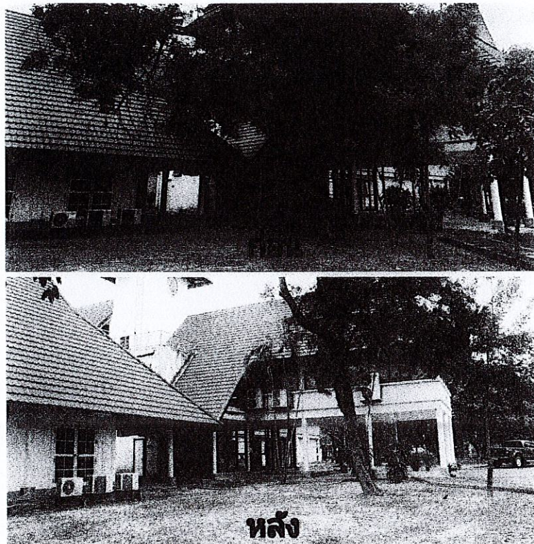
ภาพบริเวณรอบอาคารหอจดหมายเหตุแห่งชาติเฉลิมพระเกียรติฯ อุบลราชธานี
