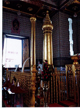
เสาหลักเมืองกรุงเทพฯ เป็นเสาหลักเมืองที่มีแกนกลางเป็นไม้มงคล เพาะไม้หกชั้นประกบโดยรอบเสาแกนติดตึงด้วยหมุดโลหะ และใส่ให้กลมทั้งเสา ส่วนยอดกลึงไม้แล้วแกะสลักลวดลาย ลงรักปิดทองทั้งต้น
