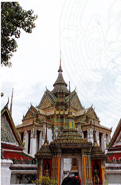
พระมณฑป ของวัดพระเชตุพนวิมลมังคลาราม ยอดทรงมงกุฎประดับกระเบื้องเคลือบ สร้างโครงสร้าง ด้วยวิธีกลี้ง ไล่นุ่นและการปั้นด้วยปูนปั้น
