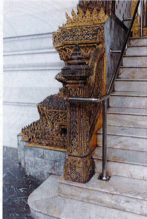
เสาเม็ดหัวบันไดทางเข้าพระอุโบสถ วัดพระเชตุพน วิมลมังคลาราม กรุงเทพฯ สร้างด้วยกระบวนช่างไสปูน และปั้นประดับลวดลายด้วยปูนปั้น ลงรักปิดทองประดับ กระฉก
