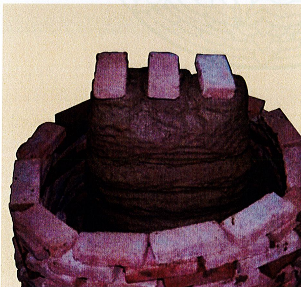
วางอิฐปิดปากกรูเท ใช้ดินและทรายพอกภายนอกเตา
