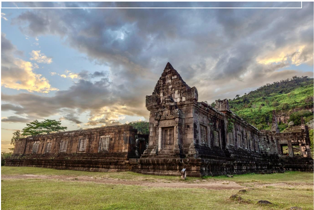
อาคารที่ได้รับการบูรณะภายใต้กรอบความร่วมมือของประเทศไทย - อินเดีย
