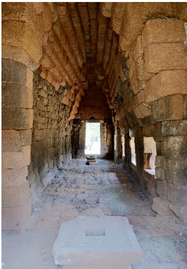
ภาพ สภาพปัจจุบันภายในอาคารประธาน ปราสาทบ้านบุ
