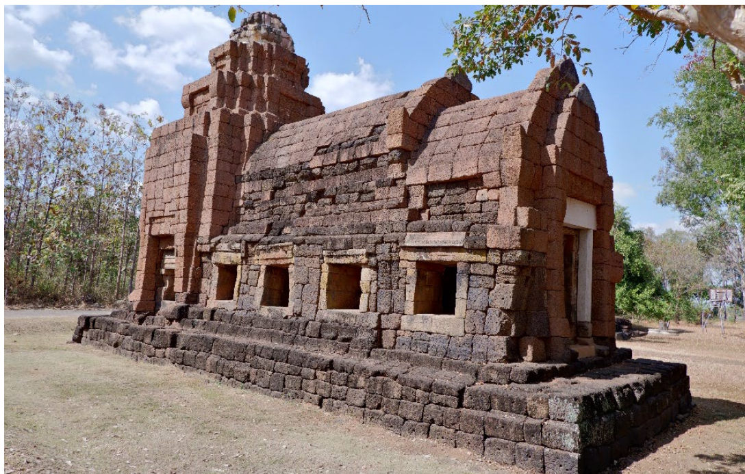
ภาพ สภาพปัจจุบันอาคารประธานปราสาทบ้านบุ
