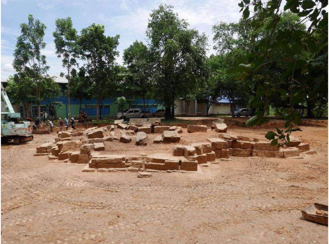
ภาพที่ ๒ ปราสาทบ้านนุใหญ่ หลังการขุดแต่ง
