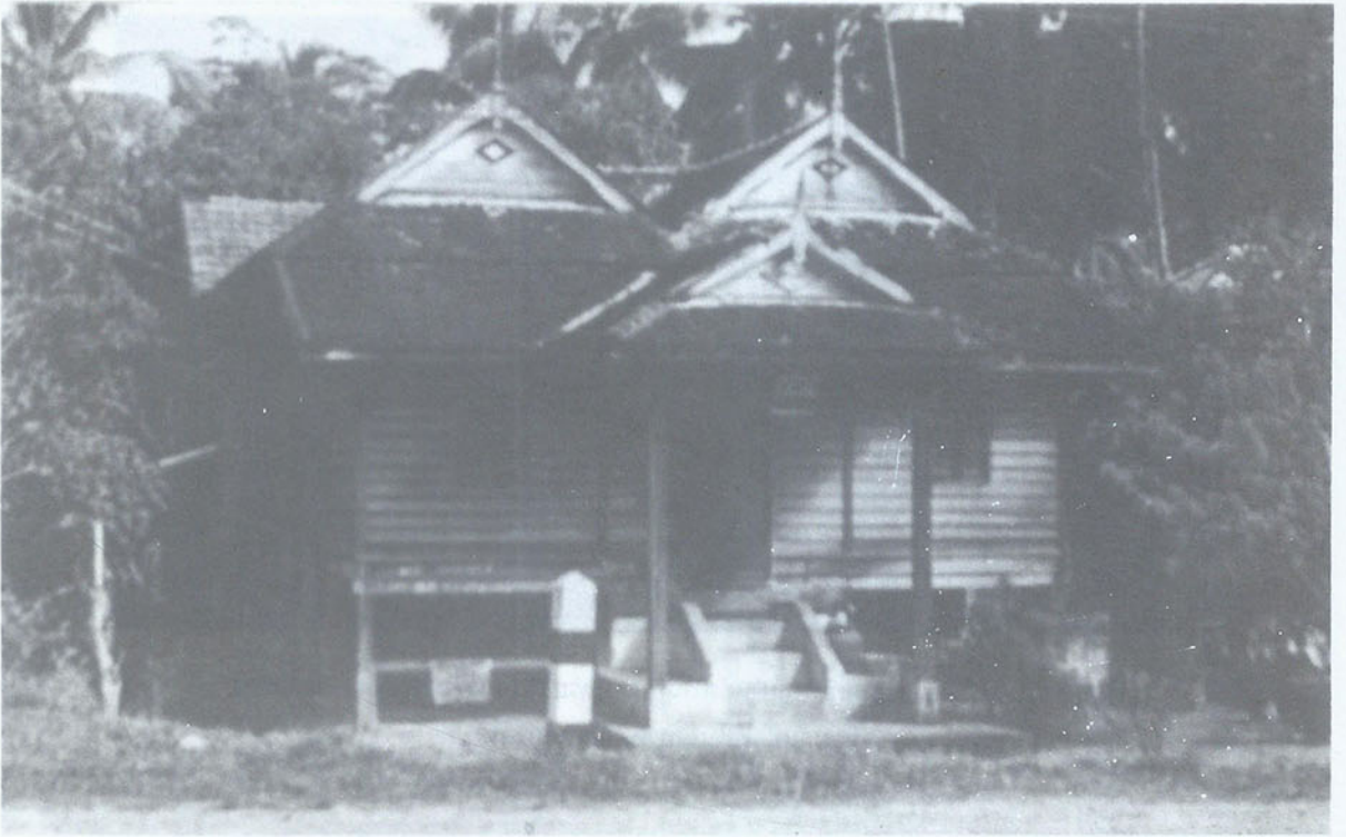
เรือนไทยภาคใต้ แบบเรือนเครื่องสับ หลังคาแบบ "บลานอ" นิยมกันมากในกลุ่มชาวไทยมุสลิมจังหวัดชายแดนภาคใต้
