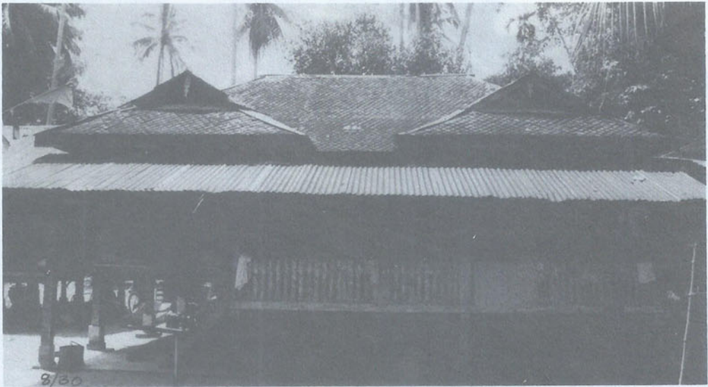
เรือนไทยภาคใต้ แบบเรือนเครื่องสับ หลังคาแบบ "บลานอ" (และมีการต่อเติมในภายหลัง) นิยมกันทั่วไปในจังหวัดชายแดนภาคใต้
