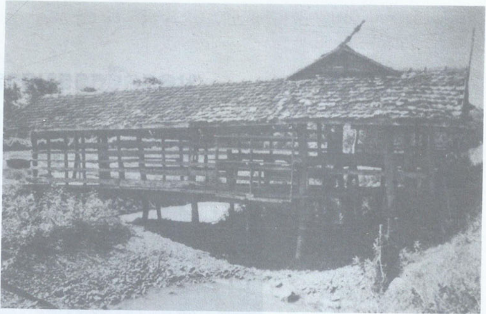
ศาลากลางหนหลังคาจั่ว ใช้เป็นสะพานข้ามคูน้ำไปในตัว
