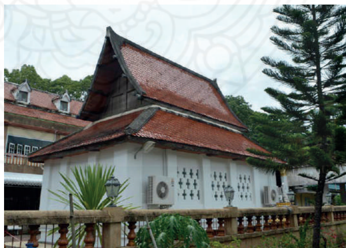
• อาคารก่ออิฐเป็นผนังจากวัดชายนาวา อำเภอเมืองฯ จังหวัดนครศรีธรรมราช
