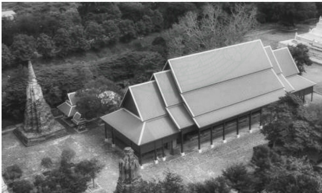
งานก่อสร้างอาคารคลุมพระอุโบสถแล้วเสร็จ
