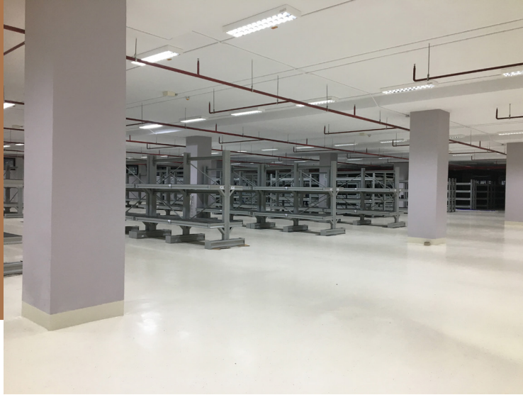
สภาพปัจจุบันของห้องคลังเก็บโบราณวัตถุและศิลปวัตถุประเภทหิน ซึ่งอยู่ในระหว่างการติดตั้งอุปกรณ์จัดเก็บและระบบอาคาร
