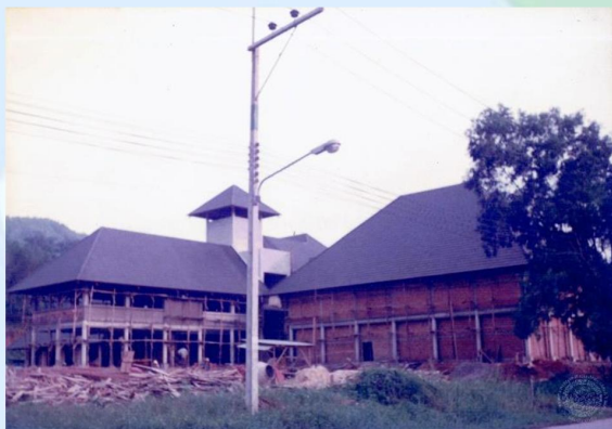
ภ หจข สข /๒๕๓๖.๒/๐๐๒ การก่อสร้างตัวอาคาร หอจดหมายเหตุแห่งชาติเฉลิมพระเกียรติฯ สงขลา
