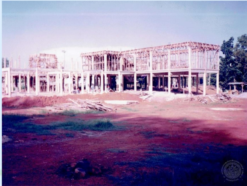
ภ หจข สข /๒๕๓๖.๒/๐๐๑ การก่อสร้างตัวอาคารหอจดหมายเหตุแห่งชาติ เฉลิมพระเกียรติ สมเด็จพระนางเจ้าสิริกิติ์ พระบรมราชินีนาถ สงขลา
