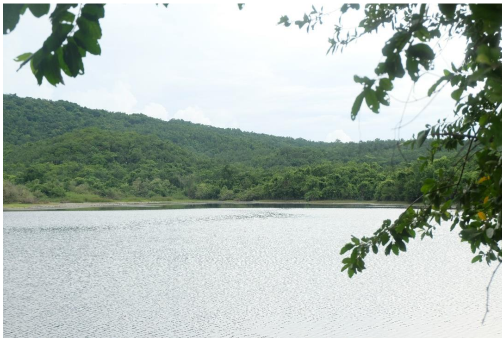
ภาพที่3.2 สภาพปัจจุบันอ่างเก็บน้ำปราสาททอง ถ่ายภาพจากทางทิศใต้ของอ่างเก็บน้ำไปทางทิศเหนือเนื่องจากทิศตะวันตก ซึ่งติดกับที่ลาดเชิงเขาของภูพนมรุ้ง จึงเป็นอ่างเก็บน้ำที่รับน้ำได้ดี
