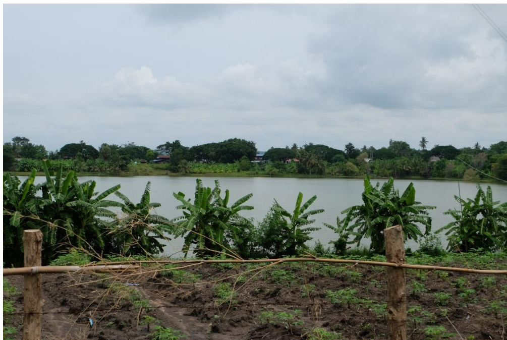
ภาพที่ 9.7 สภาพปัจจุบันคันดินบารายหนองบัวรายด้านทิศเหนือ มีการปรับใช้พื้นที่เพื่อการเกษตรกรรม
