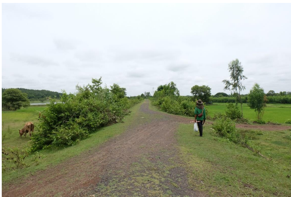
ภาพที่ 7.8 คันดินอ่างเก็บน้ำด้านทิศตะวันออก สูงประมาณ 4 เมตร โดยด้านทิศตะวันออกของอ่างเก็บน้ำเป็นพื้นที่เกษตรกรรม โดยเฉพาะการเพาะปลูกข้าว
