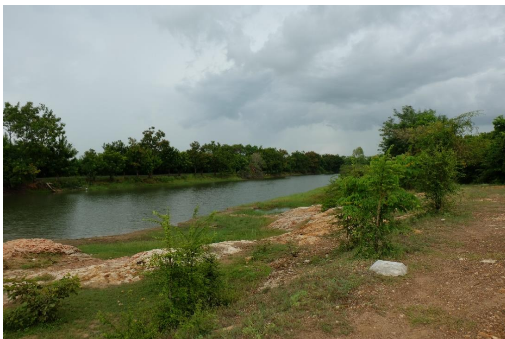
ภาพที่ 2.8 สภาพปัจจุบันอ่างเก็บน้ำเขาดิน โดยถ่ายภาพจากด้านทิศตะวันออกเฉียงใต้ของอ่างเก็บน้ำไปทางทิศตะวันตกต่อเนื่องกับทิศเหนือ ด้านทิศตะวันตกเป็นคันดินอ่างเก็บน้ำยกสูงประมาณ 3 เมตร
