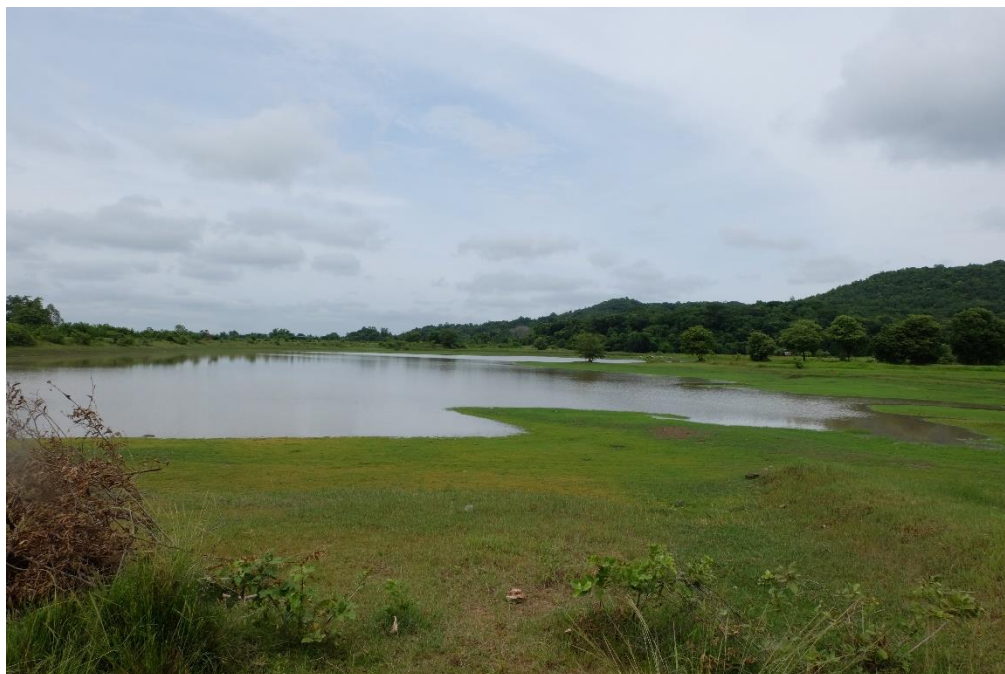
ภาพที่ 7.3 สภาพปัจจุบันอ่างเก็บน้ำห้วยลาด ถ่ายภาพจากด้านทิศตะวันตกเฉียงเหนือของอ่างเก็บน้ำไปทางทิศตะวันออกเฉียงใต้ซึ่งติดกับภูพนมรุ้ง บริเวณพื้นที่ดังกล่าวมีการปรับใช้พื้นที่เพื่อการเกษตรกรรมและเลี้ยงสัตว์
