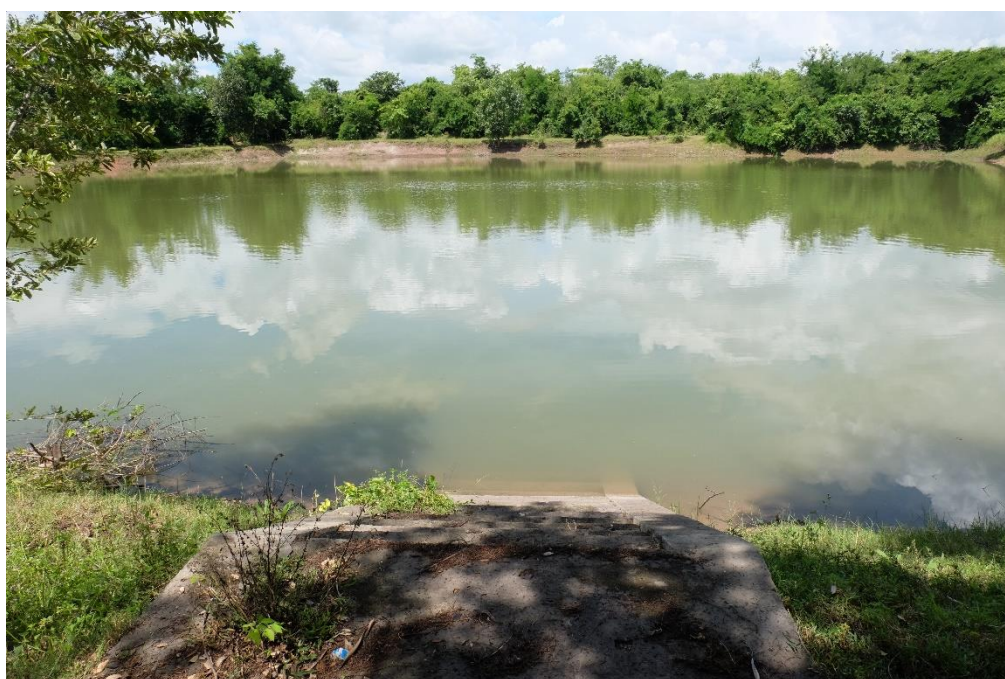
ภาพที่12.6 มีการปรับปรุงพื้นที่ด้านทิศตะวันตกด้วยการจัดทำบันไดทางขึ้น-ลง ของอ่างเก็บน้ำ
