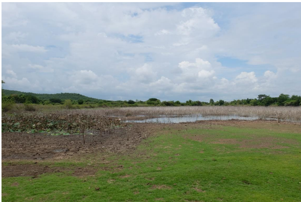
ภาพที่1.4 สภาพปัจจุบันอ่างเก็บน้ำเมื่อนฮอร์ โดยบางจุดของอ่างเก็บน้ำมีปริมาณน้ำน้อย
