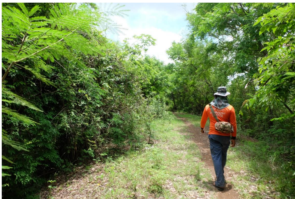
ภาพที่11.6 สภาพคันดินอ่างเก็บน้ำด้านทิศตะวันตก
