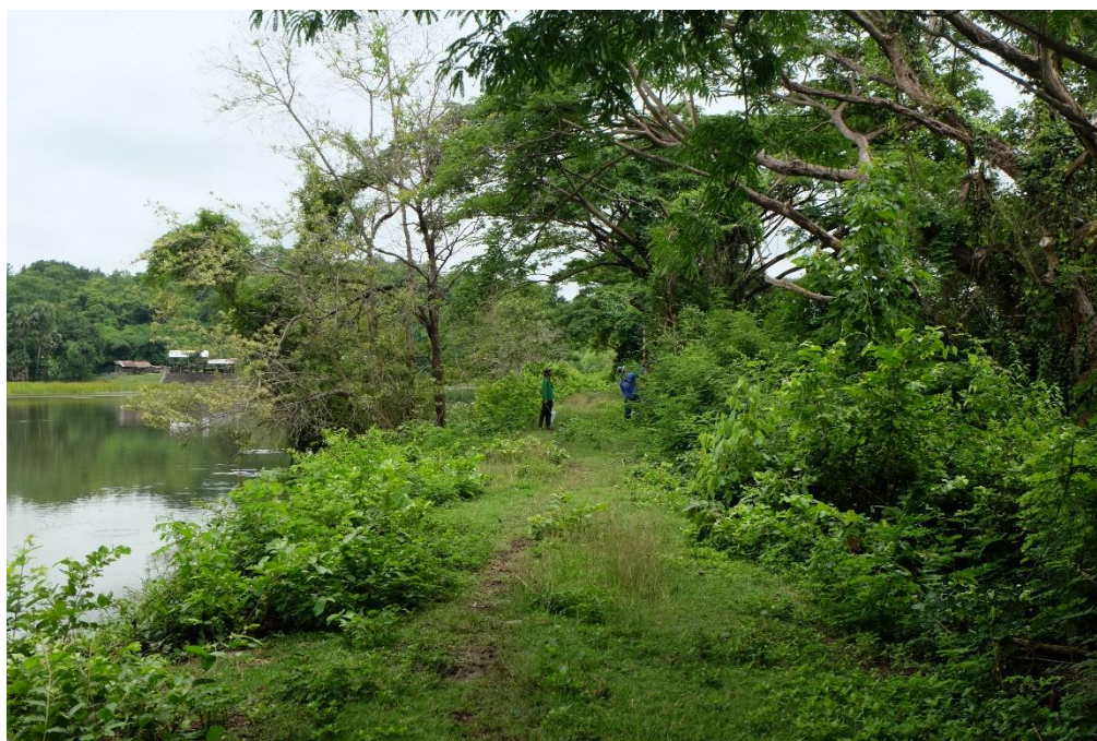
ภาพที่ 8.9 สภาพปัจจุบันของคันดินกั้นอ่างเก็บน้ำระหว่างอ่างเก็บน้ำห้วยสลักไถ่ (ด้านทิศตะวันตก) กับอ่างห้วย สลักไถ่ (ด้านทิศตะวันออก) โดยอ่างเก็บน้ำด้านทิศตะวันตกสูงกว่าด้านทิศตะวันออกประมาณ 3 เมตร
