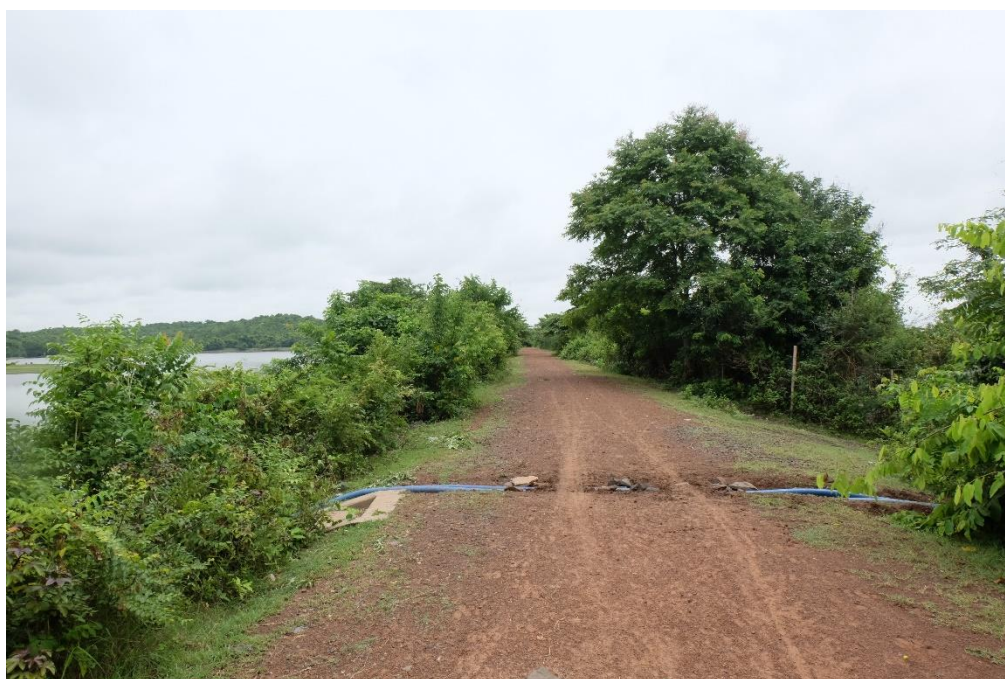
ภาพที่ 6.8 คันดินอ่างเก็บน้ำด้านทิศตะวันออก สูงประมาณ 4 เมตร โดยด้านทิศตะวันออกของอ่างเก็บน้ำเป็นพื้นที่ เกษตรกรรม โดยเฉพาะพื้นที่เพาะปลูกข้าว
