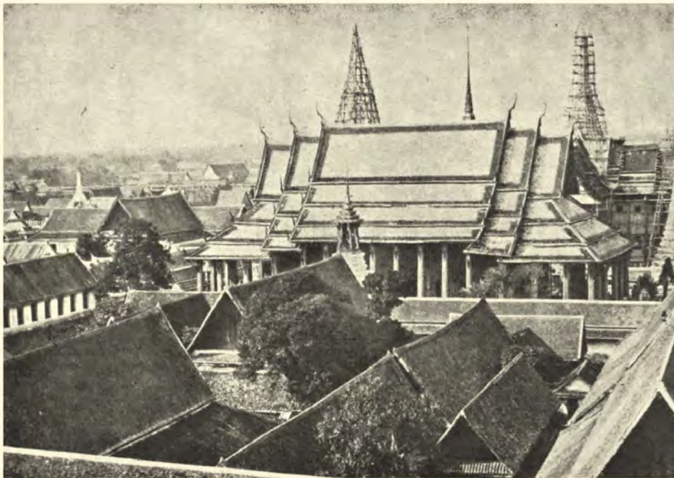
อาคารที่เห็นแต่หลังคา คือ โรงแสง ในรัชกาลที่ ๕ โปรดเกล้าฯ ให้ริ้วโรงแสงสร้างพระที่นั่งบรมพิมาน
