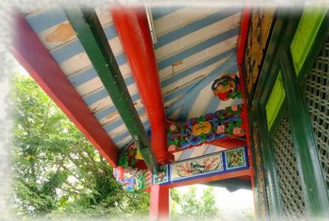
การตกแต่งที่ โครงสร้างรับน้ำหนัก
