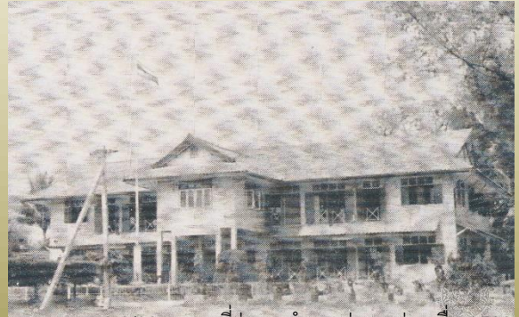
ภ.สพ.สบ.2.2/83 อาคารที่ว่าการอำเภออุ้มทอง ถ่ายเมื่อ 2523
