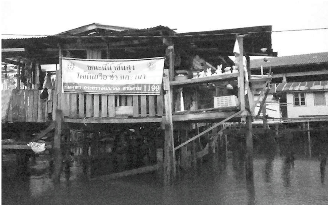
ป้ายประกาศแจ้งเตือนของกรมเจ้าท่าบริเวณคลองบางกอกน้อย เพื่อให้เดินเรือช้าและเบา
