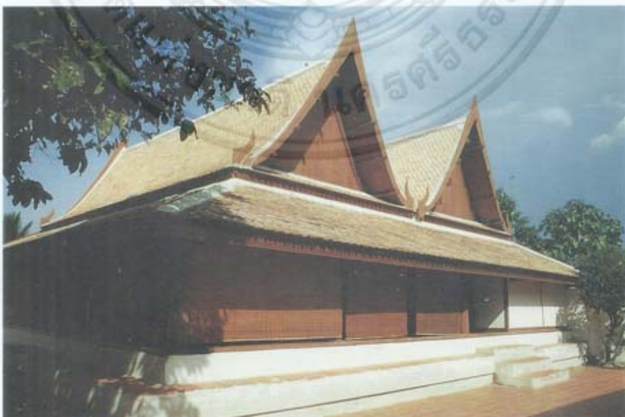
อาคารเรือนประฐาน ด้านทิศใต้ หลังการบูรณะ
