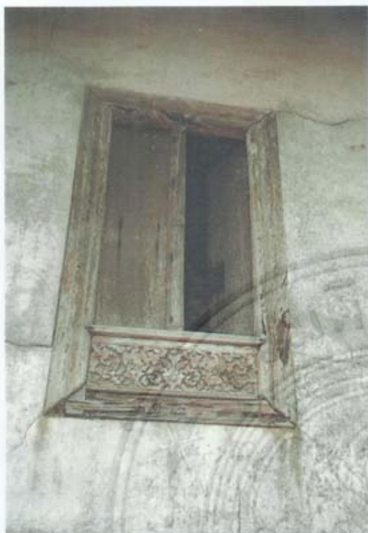
บานหน้าต่างและลวดลาย ก่อนการบูรณะ
