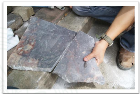
ภาพที่ ๔.๑.๒ ข การกลับด้านเลื่อยและกะเทาะหินสปูออก
