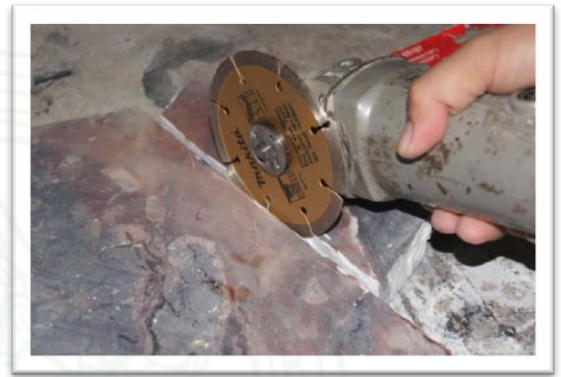
ภาพที่ ๔.๑.๑ ค การตัดหินสปูด้วยลูกหมู
