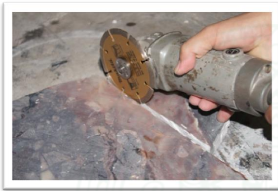
ภาพที่ ๔.๑.๑ ค การตัดหินสปูด้วยลูกหมู
