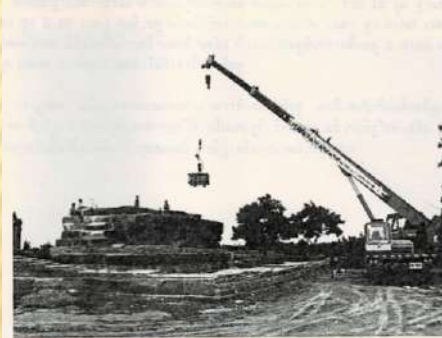
ปราสาทประธาน ด้านทิศตะวันตกเฉียงเหนือ ขณะขุดลอกคูน้ำรอบปราสาท
