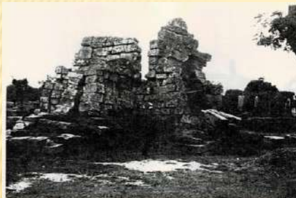
โคปุระ ด้านทิศตะวันตกเฉียงเหนือ ก่อนทำการบูรณะ
