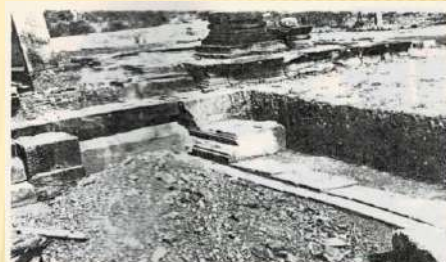
ฐานปัทมปราสาท และผนัง (IM-1) ด้านทิศตะวันตกเฉียงเหนือ เมื่อถูกเพลิงไหม้บริเวณประตูหิน
