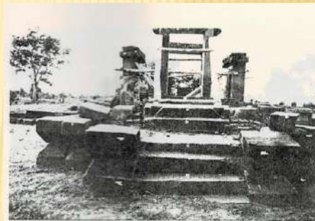
ภาพ (TH-1) ด้านทิศเหนือ เมืองศรีวิชัย จังหวัดภูเก็ต ก่อนทำการบูรณะ
