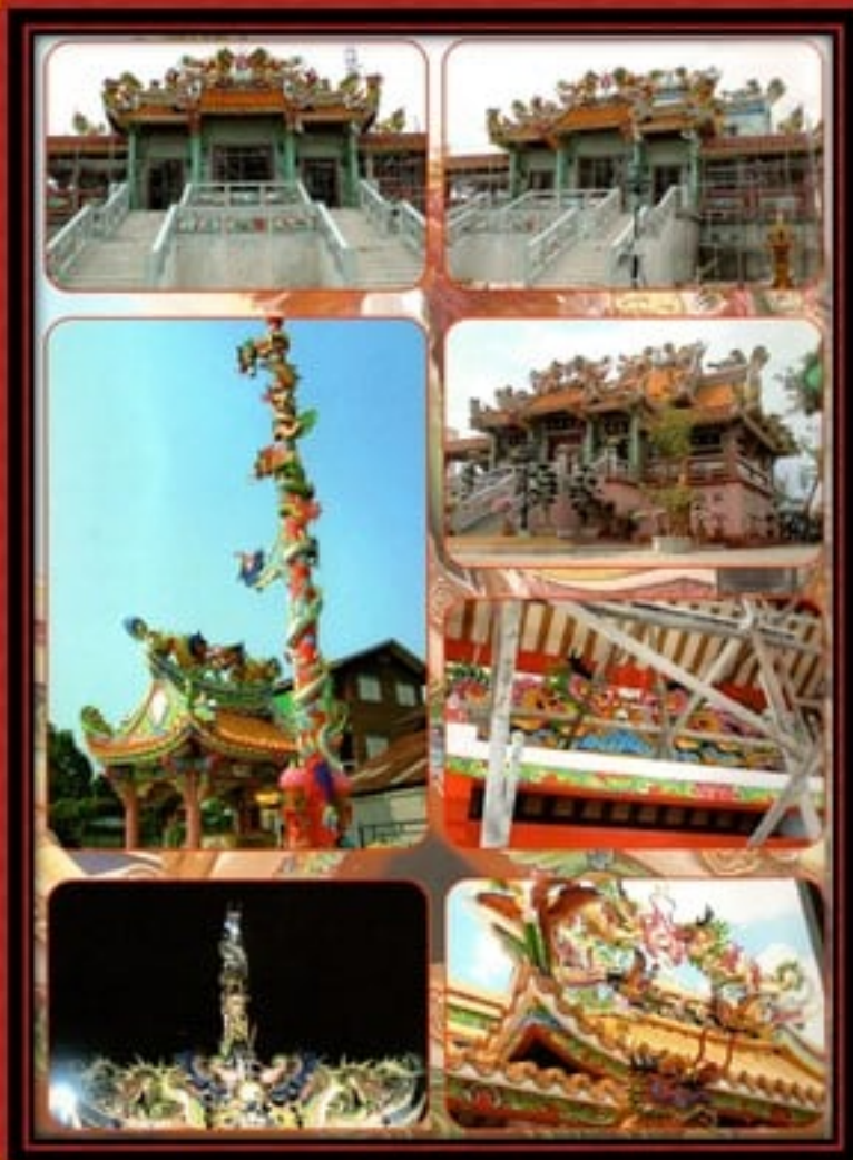
การบูรณะซ่อมแซมศาลเจ้าพ่อกวอนอู
