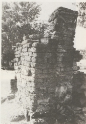
ภาพที่ ๔๐ รางตะเลียงคู้มประตูล้ำวร้าง (สังเกตจาก โถงคั่นบน)
