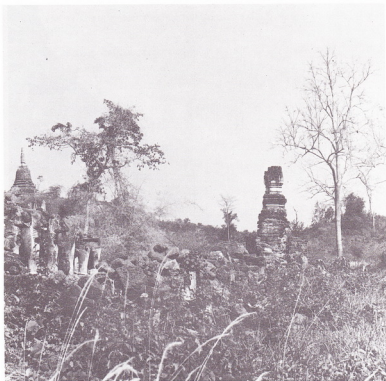
ภาพที่ ๕ กำแพงแก้วและฐานประติมากรรมที่ศตวรรษออกเฉียงเหนือก่อนการขุดแต่งปี พ.ศ. ๒๔๐๘
