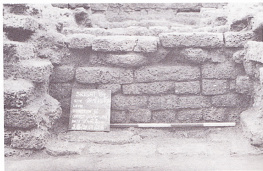
ภาพที่ ๘๘ หลุมทดสอบที่ ๔ แนวฐานอาคารรองรับรูปช้าง (แนวใน) ก่อเรียงแบบ ENGLISH BOND ชัดเจน (แนวชั้นในเป็นฐานส่วนที่ไม่ถูกบูรณะ)
