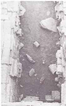
ภาพที่ ๑๐๔ หลุมทดสอบที่ ๔ พื้นดินถมบริเวณ ใต้ฐานอาคารรองรับช้าง
