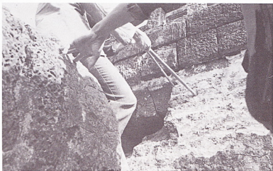
ภาพที่ ๗๘ ผังด้านทิศใต้ การดำเนินการขูดเปิดผนังด้วยเครื่องมือขนาดเล็ก
