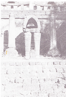
ภาพที่ ๕๒ รูปด้านตัดด้านหัวข้างทิศเหนือจะเห็นลักษณะการทำโค้งครึ่งวงกลม
