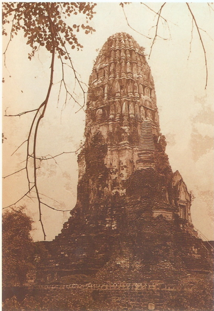
ปรังค์ประธานวัดราชบูรณะ (ก่อนการบูรณะ) รูปแบบสถาปัตยกรรมที่นิยมสร้างในสมัยอยุธยาตอนต้น
