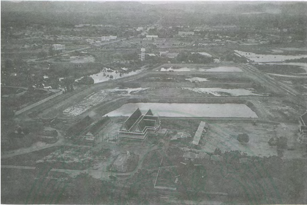
วัดธรรมิการามวรวิหาร คณะใต้ ที่เห็นเบื้องหน้าเป็นบ่อบำบัดน้ำเสียของเทศบาลเมืองประจวบฯ
