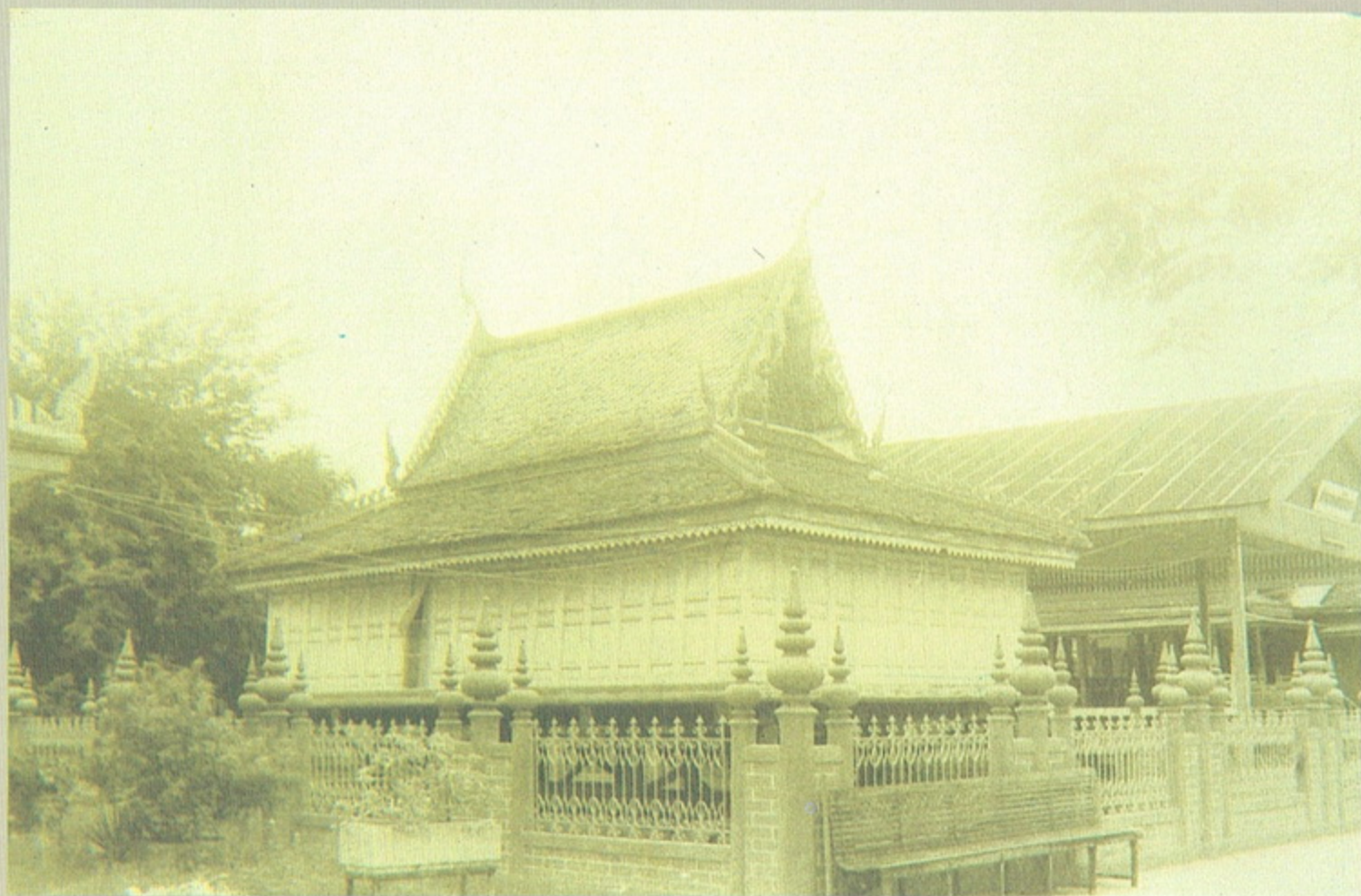
หอไตร วัดกลางบางแก้ว อ. นครชัยศรี จ. นครปฐม
